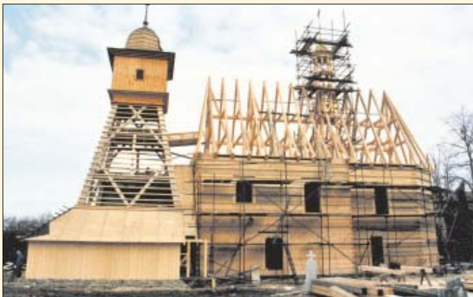
Stavba přesné repliky vyhořelého kostela (16. 3. 2004).
