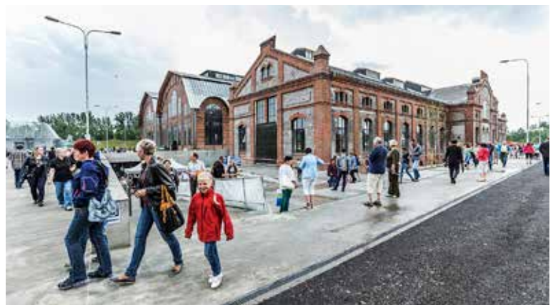
Trojhalí ožilo. Vpředu budova ústředny, za ní dvojlodní hala elektrocentrály
