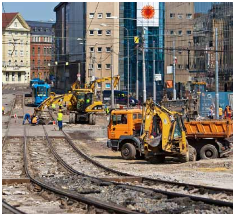
Výstavba tramvajových zastávek u Nové Karoliny si do 17. srpna vyžádá výluku tramvajové dopravy. Celá stavba má být hotova do 30. září 2012.
