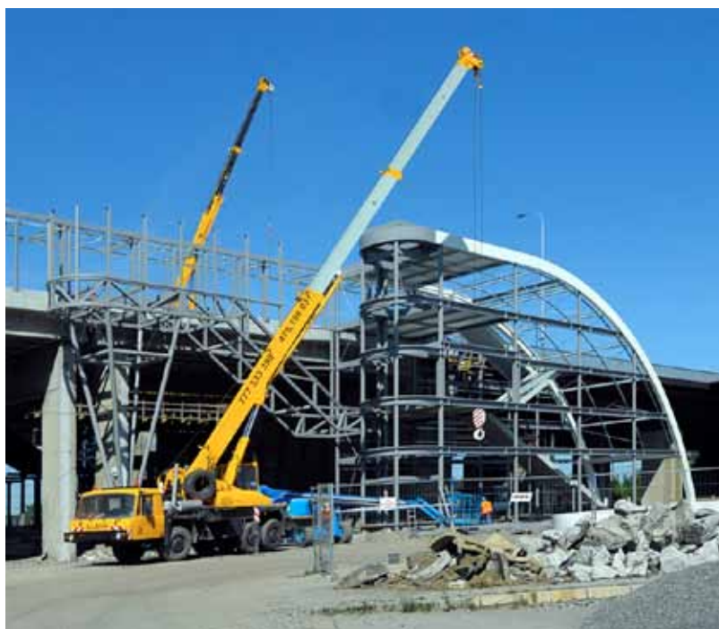
Na Svinovských mostech se rýsují první konstrukce budoucího dopravního terminálu.
