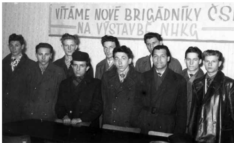
„Naděšení“ noví brigádníci na stavbě NHKG
