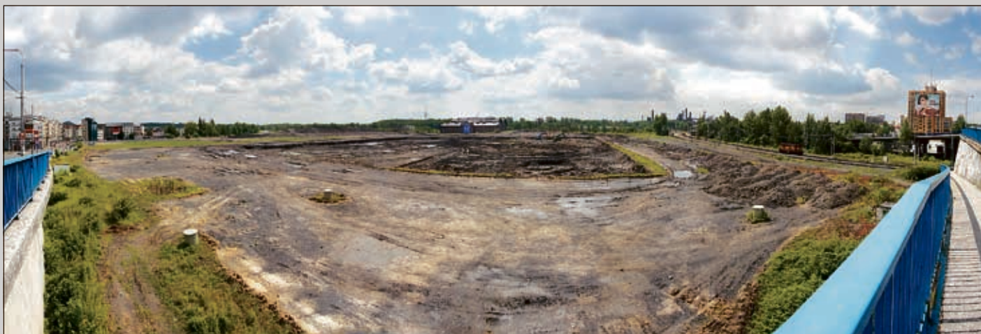
Panoramatický záběr současného staveniště Nové Karoliny bude mít za pár měsíců historickou hodnotu
