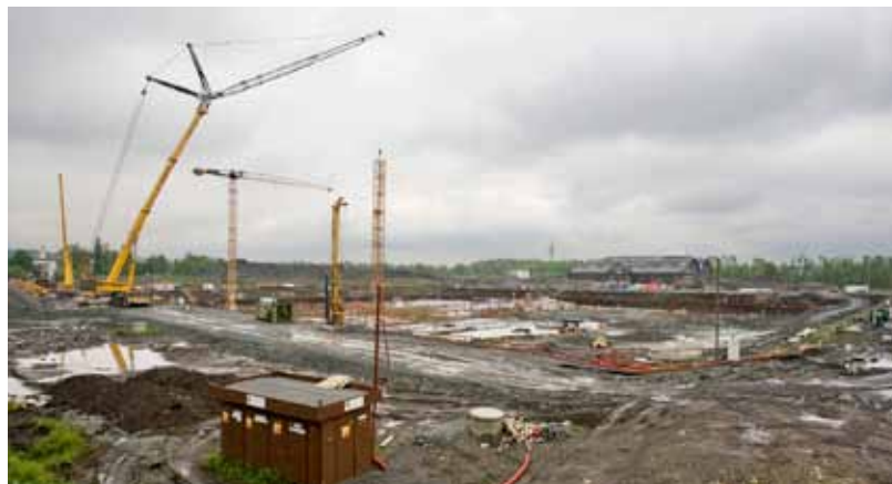
Rušné tempo stavby přerušilo odčerpávání vody, výstavba však pokračuje.
