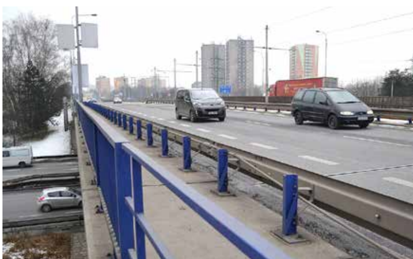
Most přes Rudnou, který nahradí nová mostní konstrukce.
