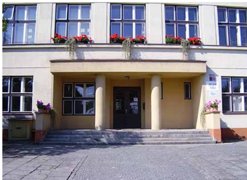
Budova ZŠ v Ostravě-Hošťálkovicích před rekonstrukcí
