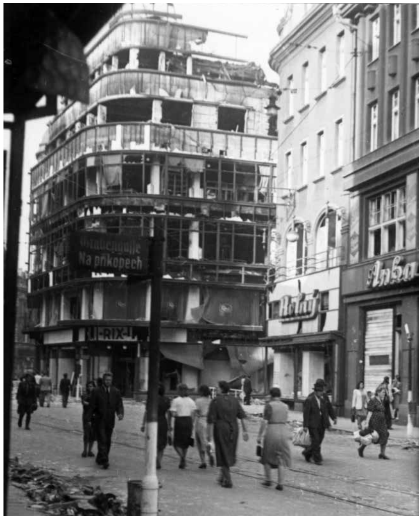
I po ničivém spojeneckém náletu se do ulic Moravské Ostravy vracel život. Vzadu je poškozený obchodní dům RIX (zbořen v roce 1945), na jehož místě na křižovatce ulic 28. října a Vojanovy dnes stojí banka a restaurace.
