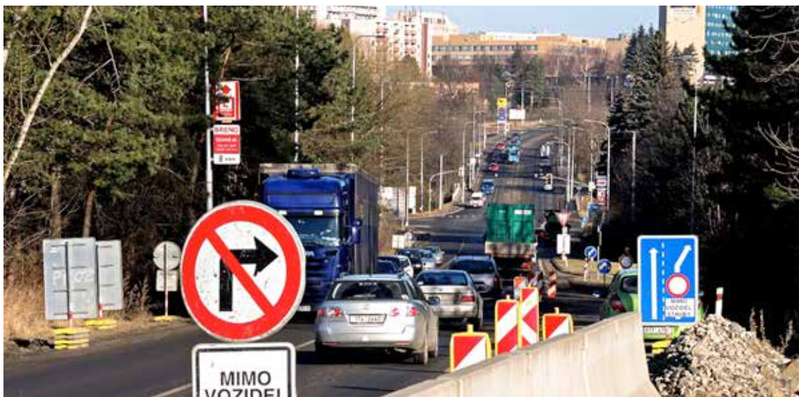
Výstavba Prodloužené Rudné pokračuje v prostoru budoucí mimoúrovňové křižovatky s ulicí 17. listopadu v Porubě
