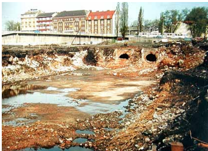
V roce 1999 začala dekontaminace území Karoliny, tisíce kubíků zeminy putovaly do Zárubku, kde se čistily metodou tzv. biodegradace.
