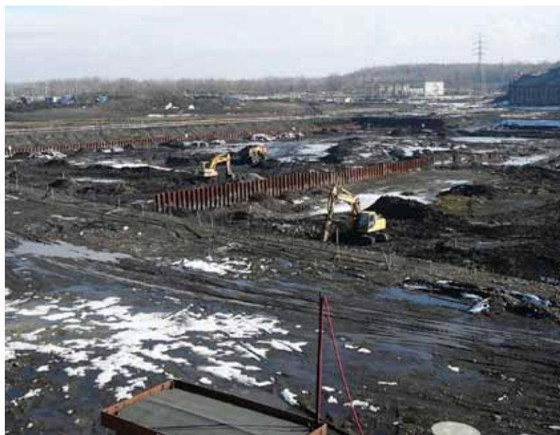
V roce 2010 začalo hloubení základů budoucího obchodního centra.
