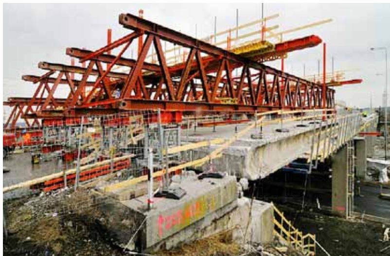
Příhradové konstrukce slouží ke zvedání Svinovských mostů.
