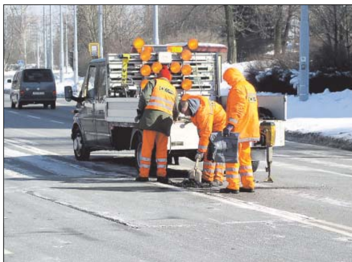
Silničáři opravují v zimním období výtluky studenou obalovanou směsí.
