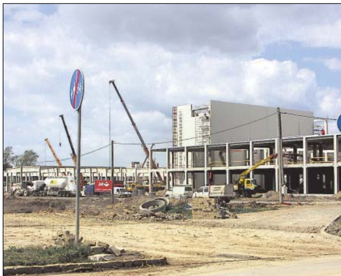
V průmyslové zóně Hrabová vládne čilý stavební ruch.
