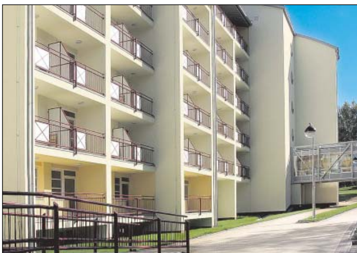
DOMOV DŮCHODCŮ V NOVÉM. Domov důchodců v Opavské ulici v Porubě byl slavnostně otevřen po ukončení druhé etapy rozsáhlé rekonstrukce 10. října. Novou podobu i vnitřní vybavení získala budova bývalého domova-penzionu, postavena byla propojovací chodba, nechýbí ani úpravy zahrady. Finanční náklady na stavební práce byly vyčísleny na 362 milionů korun.
