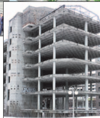
Betonový skelet v ul. 28. října.
