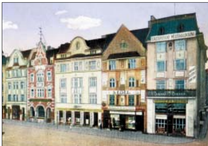
Dům po přestavbě před rokem 1918.
