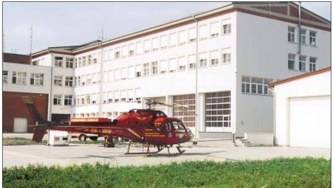
HELIPORT. V říjnu letošního roku bude dokončena III. etapa výstavby heliportu v zábřežském areálu Hasičského záchranného sboru. Investorem je statutární město Ostrava, zhotovitelem akciová společnost Stavos Stavba, projektantem Ateliér Idea, spol. s r. o. Stavba pětipodlažního objektu, který budou využívat nejen krajiští a městští hasiči, ale i letecká záchranná služba byla zahájena v listopadu 2000. Celkové náklady na vybudování tohoto moderního zázemí s novými garážemi, čerpací stanicí pohonných hmot apod. představují částku v objemu zhruba 153,3 milionu korun, které uvolnilo ze svého rozpočtu město. Dotace ze státních zdrojů - z ministerstva vnitra činila v loňském roce patnáct, letos deset milionů korun. (m)
