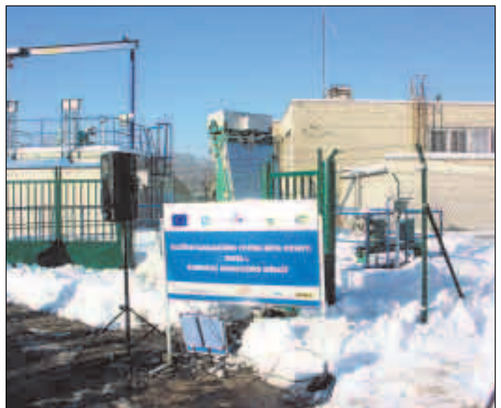
Nově vybudovaná čerpací stanice odpadních vod v Ostravě-Muglinově.
