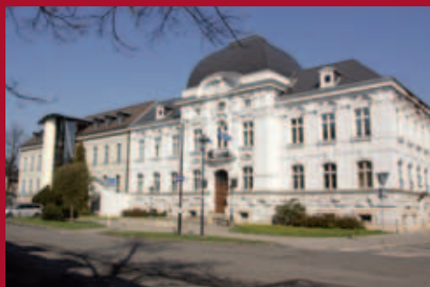
Archiv města Ostravy na Špálově ulici 19 v Moravské Ostravě, původně radnice Přívozu z roku 1897, dílo architekta Camilla Sitteho
