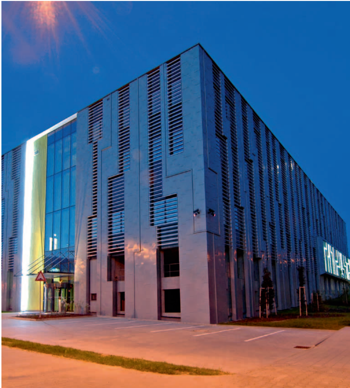
Budova pro superpočítač IT4Innovations The IT4Innovations supercomputer centre
