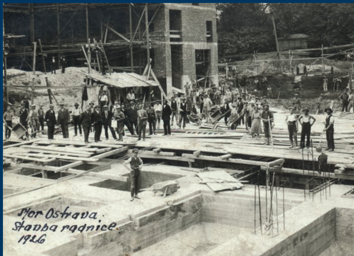
Pracovníci na stavbě. Workers at the building site.
