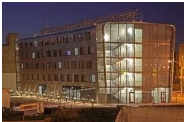
Near North Apartments a vestavěné obnovitelné zdroje energie
