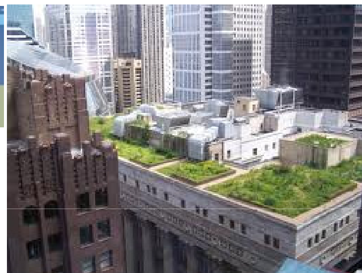
Střešní zahrady – Chicago City Hall
