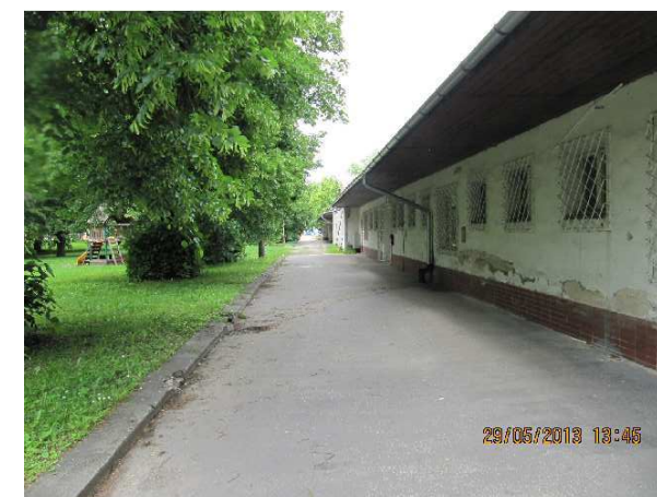
Objekt SMO, Centrum pro rodinu (špatný technický stav)
