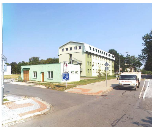
Stávající hlavní vstup do areálu OU poblíž ústí ul. Rostislavovy (v pozadí budova ZO)
