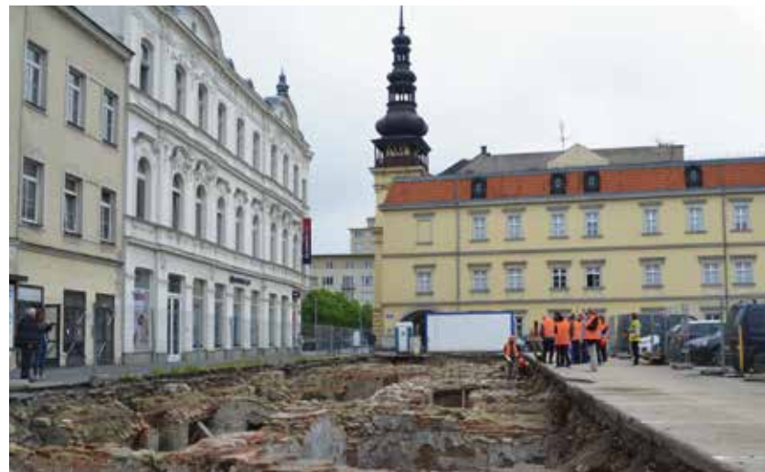
Odkrytá sklepení v místě, kde stávaly ostravské „lauby“.
