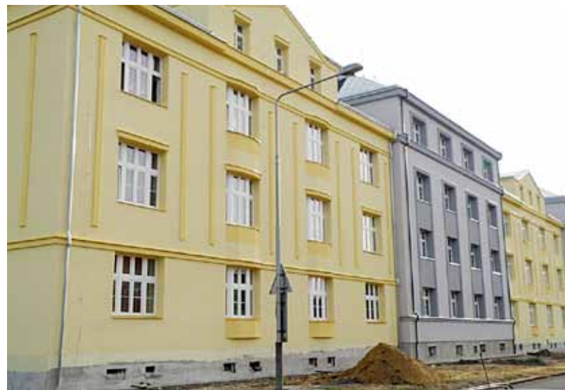
...a po rekonstrukci
