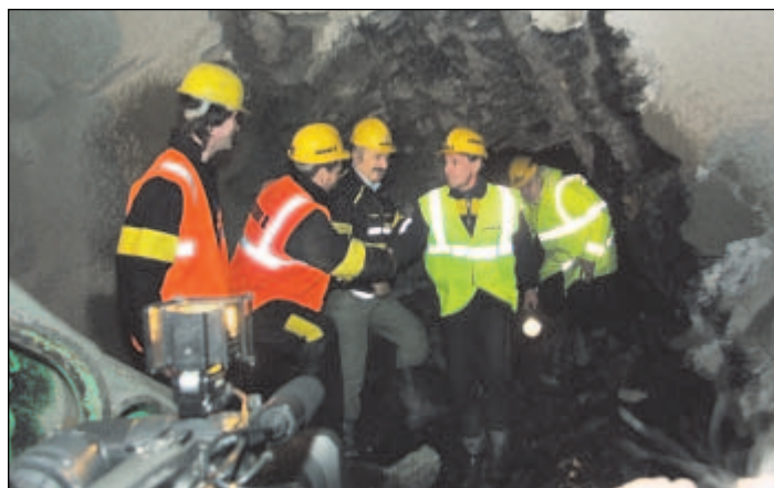
RAŽBA TUNELU. Součástí stavby dálnice D47 na trase Bílovec – Ostrava je tunel Klimkovice. Jeho ražba začala v dubnu tohoto roku. Raziči 12. prosince propojili první tubus tunelu, který má být 1 087 m dlouhý a vyžádá si finanční krytí přes 2,4 miliardy korun.
