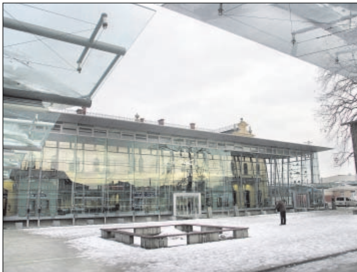
Rekonstrukce a dostavba odbavovací haly a revitalizace přednádražního prostoru železniční stanice Ostrava-Svinov si vyžádala 233 milionů Kč. Propojení se svinovskými mosty by mělo být hotovo do tří let.
