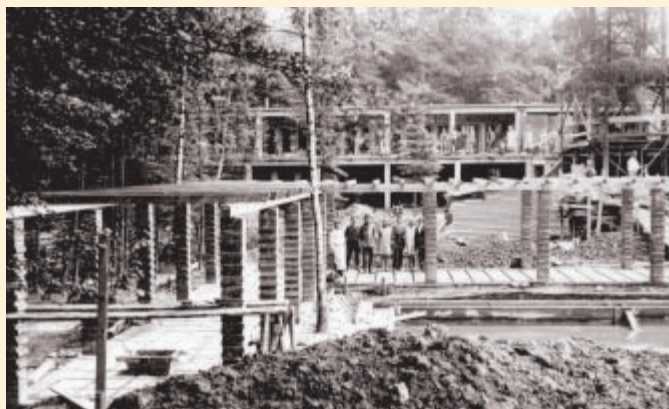
Výstavba dětského bazénu a šaten.
