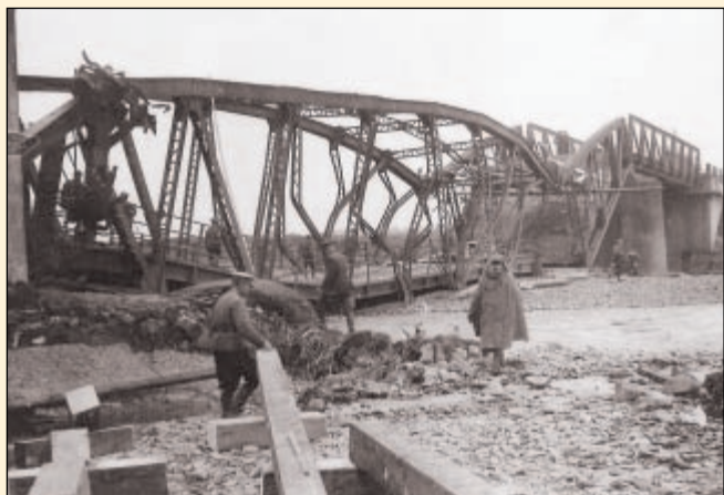
Poškozený most v Kunčicích.
