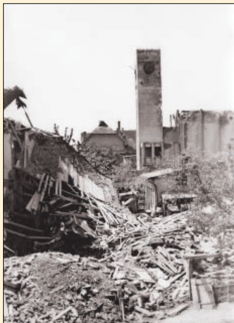
Zřícená budova Husova sboru ve Svinově.
