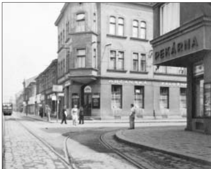
Ve 30. letech minulého století byl objekt modernizován...
