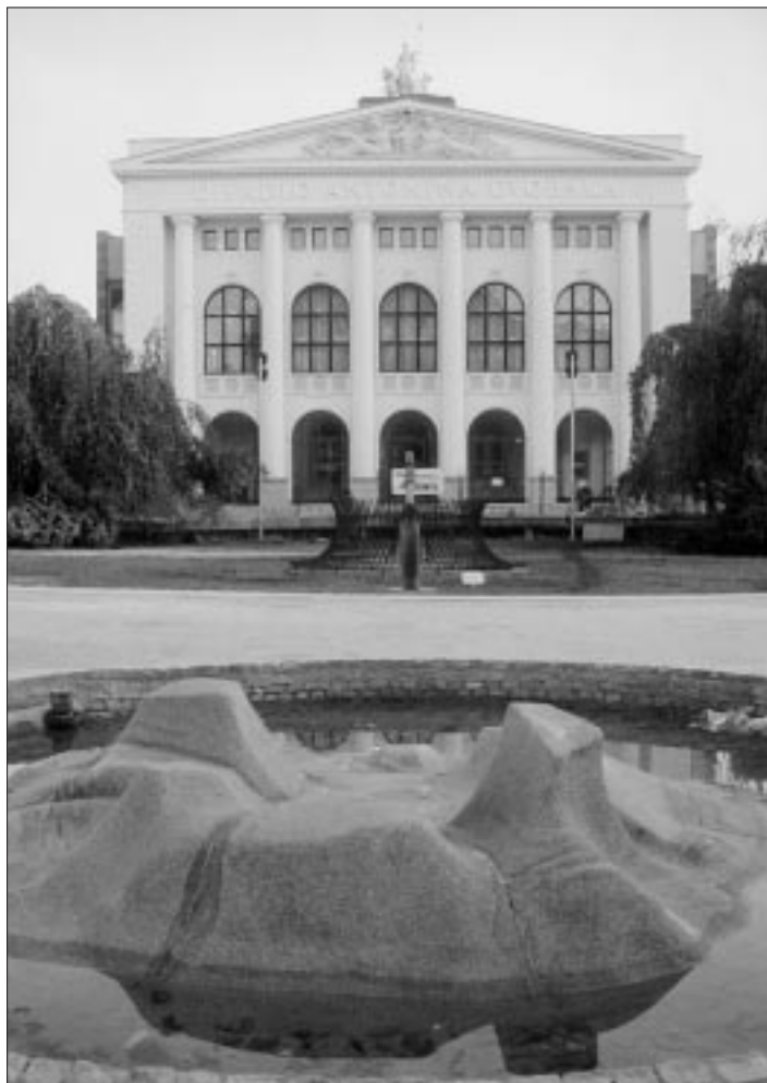
Investičně se pod realizaci tohoto díla podepsalo Město Ostrava. Dodavatelem byla akciová společnost Stavos Stavba, projektovou dokumentaci a návrhy interiéru zpracoval tým architektů z ostravské kanceláře Arkos.
