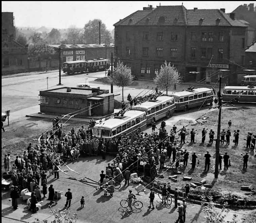
Pro zlepšení obsluhy centra města byla v Ostravě zavedena také trolejbusová doprava. Její provoz byl slavnostně zahájen 9. května 1952
